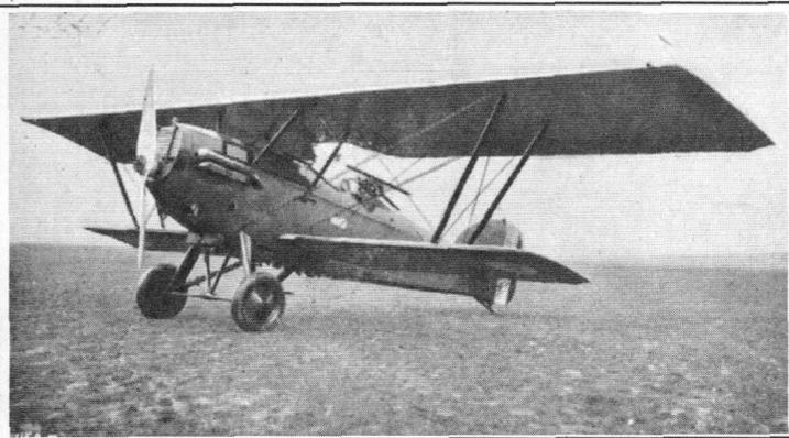
cette travée viennent se fixer les montants de la cabane qui supportent le plan central supérieur de la voilure. Au nœud des cadres avant et arrière de cette travée du fuselage, aboutissent les haubans porteurs de la cellule, ainsi que les jambes articulées du train d'atterrissage.
