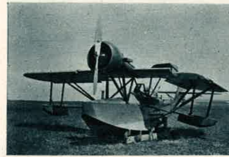
Le Potez 452 de série, demi-voilure repliée.
