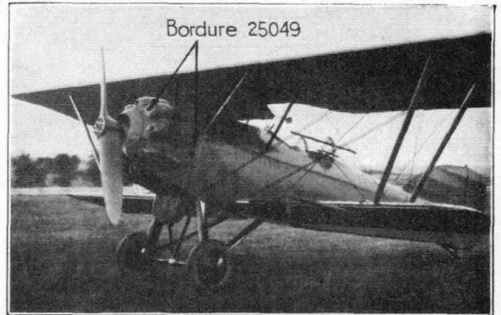
Dans l'avion POTEZ 25 les ouvertures circulaires dans les éléments de capotage du moteur sont renforcées par des bordures (acier) dont certaines, N° 25.049 ont le coefficient 12 dans l'avion.
